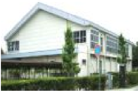
高萩中学校体育館・改築事業
