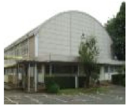
秋山中学校体育館・耐震調査
