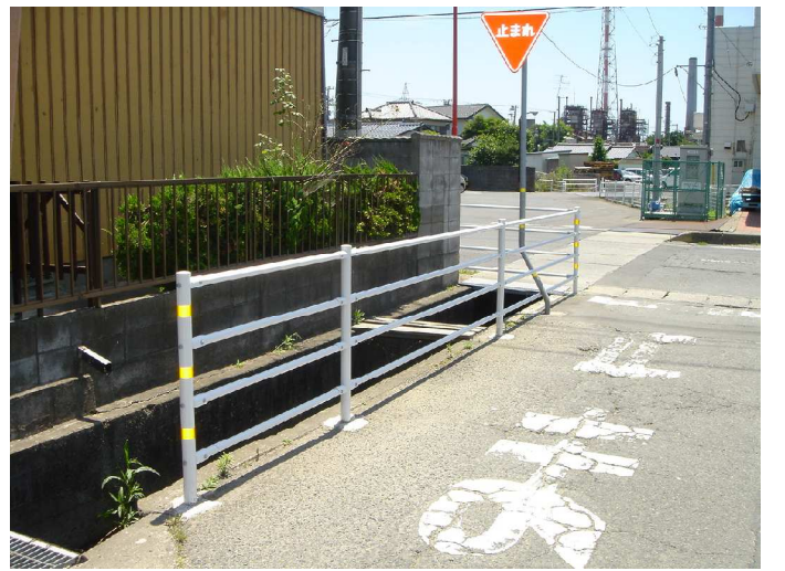
スイフ北の用水路に転落防止安全柵設置
