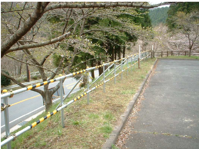
花貫ふるさと自然公園に転落防止柵設置
