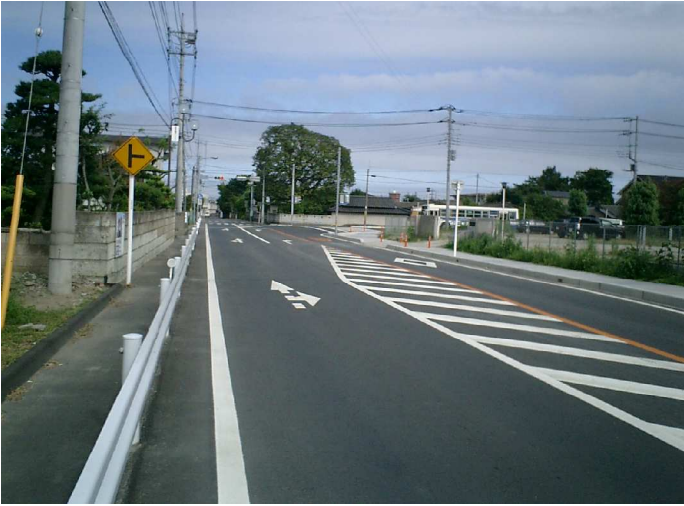
安良川西交差点に右折車線を設け改良
