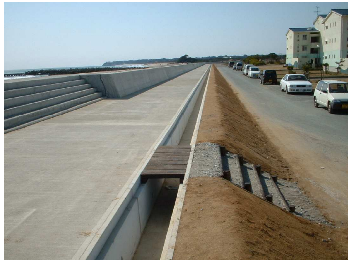
花貫堤防土手の3箇所階段設置
