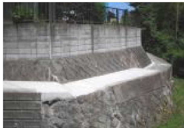
秋山幼稚園前 護岸擁壁修復
